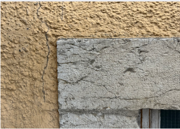
Crépi isolant minéral et conservation des encadrements en pierre naturelle.
