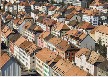
Aspect des toitures existantes et position des lucarnes à conserver.
